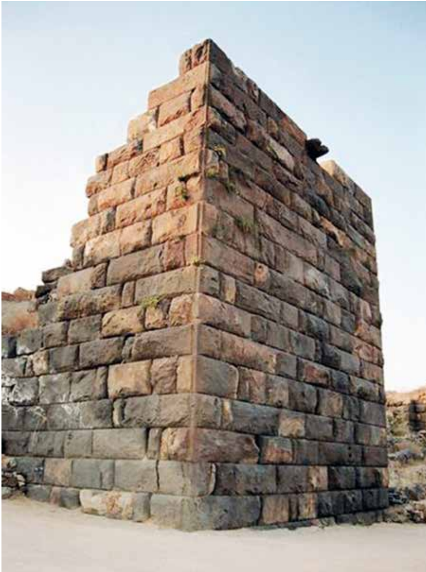
Abb. 8 Nisyros, Festung, Südturm 5, nach der Restaurierung
