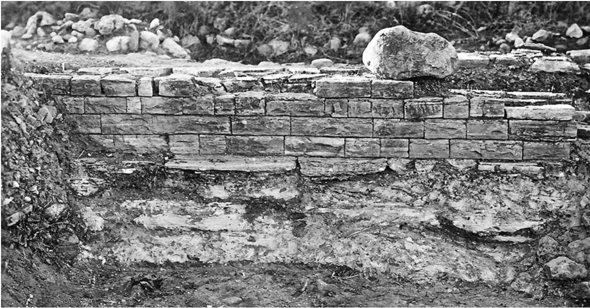
Abb. 8 Innenseite der Nordwestmauer
