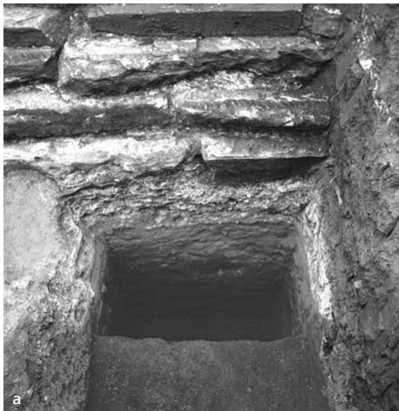
Abb. 12 a. Schnitt an der Westseite des Türwandfundaments mit Splitt- und Sandbettung unter dessen Unterkante. – b. Schematischer Querschnitt durch den Aufbau des Cellafundaments von Dipteros II (M. 1 : 100)
