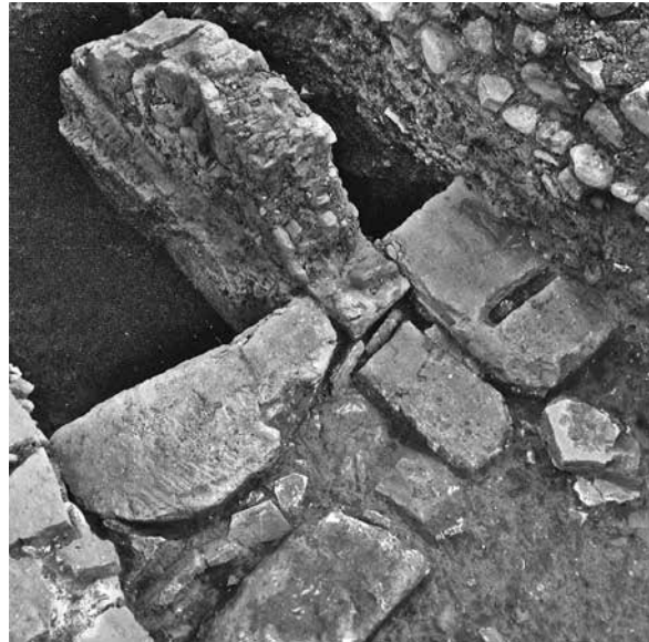
Abb. 10 Einbinden der siebten Vorlage in das Fundament der Terrassenmauer
