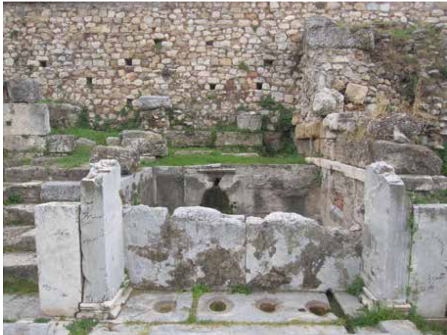
Abb. 12 Brunnen auf der römischen Agora; rechts auf der Innenseite des Orthosta- ten Flickungen aus Ziegeln und Mörtel sichtbar
