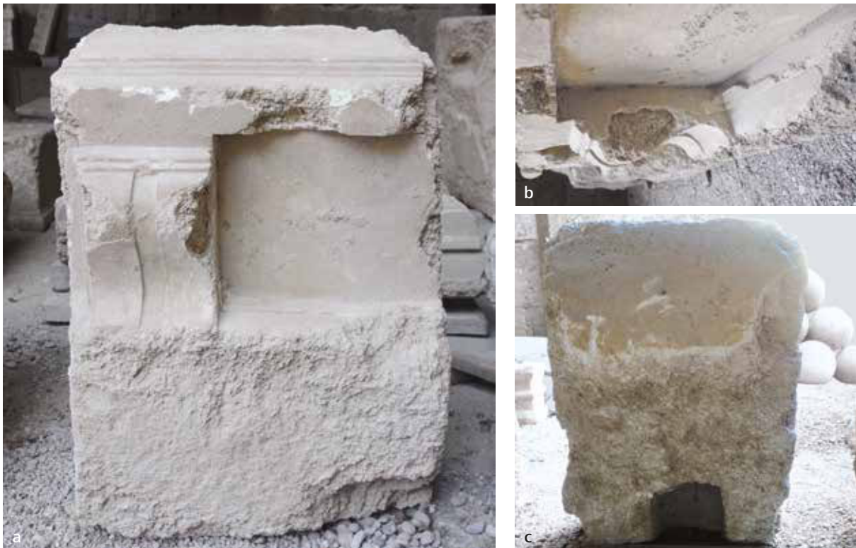
Abb. 30 Rhodos, Archäologisches Museum, Konsolengesims Kat. 9 a: a. Unteransicht. – b. Seitenansicht. – c. Oberansicht mit Putzaufleger über dem Geison und Einlassung für Balken
