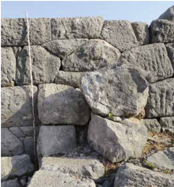
Abb. 18 Samikon, Glättungen und Bossierungen am Anschluss Kurtine 6 und Turm 5
