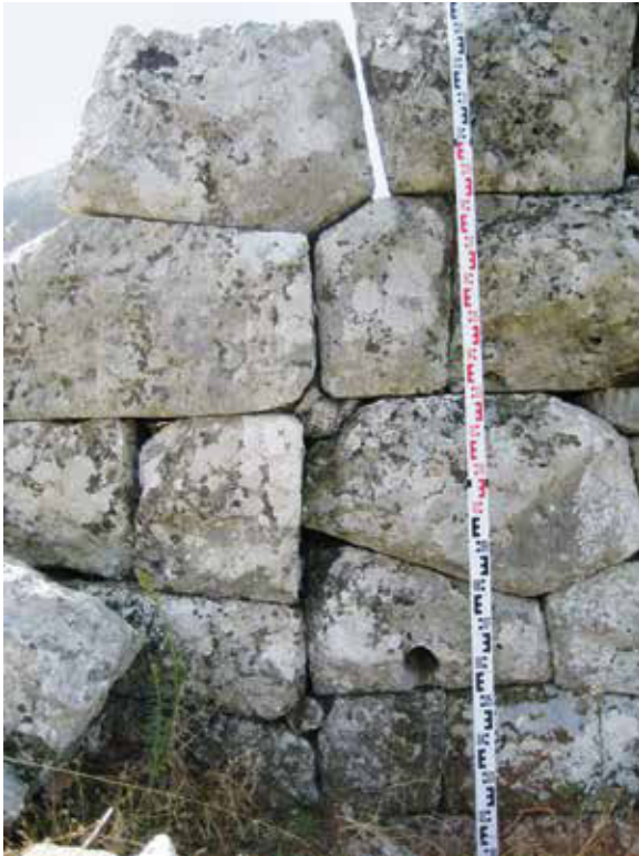
Abb. 11 Samikon, Bauabschnittsfuge an der Stadtseite von Kurtine 6a
