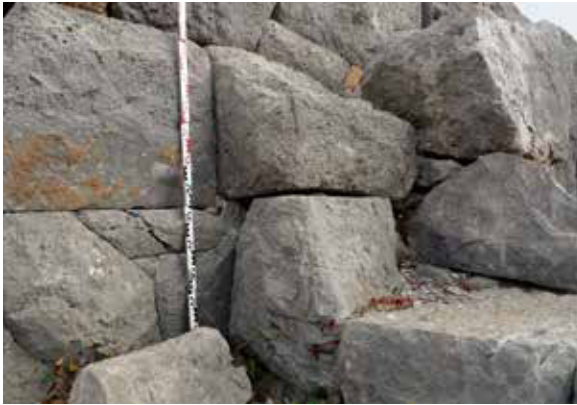
Abb. 17 Samikon, Binderstein am Anschluss Turm 5c/d
