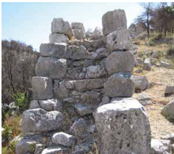
Abb. 6 Samikon, typischer zweischaliger Kurtinenaufbau
