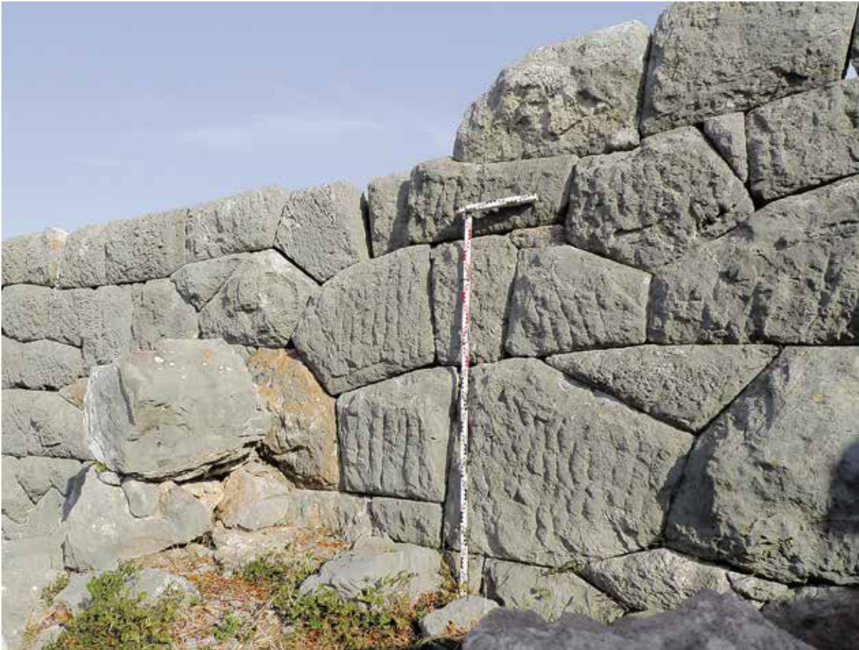
Abb. 19 Samikon, Spitzeisenrillen an der Außenschale Turm 5d
