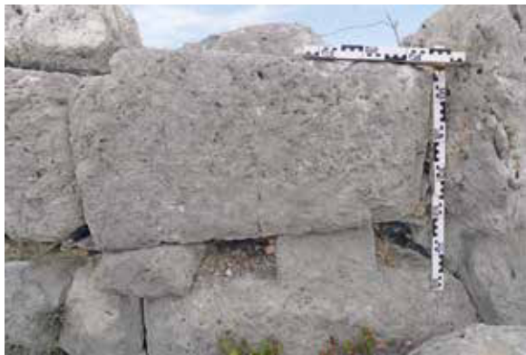
Abb. 25 Samikon, Ausarbeitungen für Balkenlöcher an der Mauer Turm 6d
