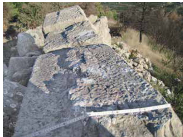
Abb. 5 Samikon, typische Bearbeitung der Lagerfugen
