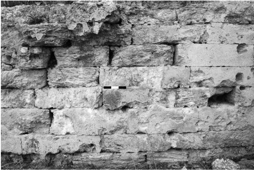
Abb. 14 Argos, Heraion, Nordhalle. Wandaufbau der Hallenrückwand ohne Orthostaten
