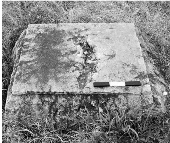
Abb. 20 Argos, Heraion, Bankettbau. Punktfundament der inneren Säulenstellung der Hofhalle
