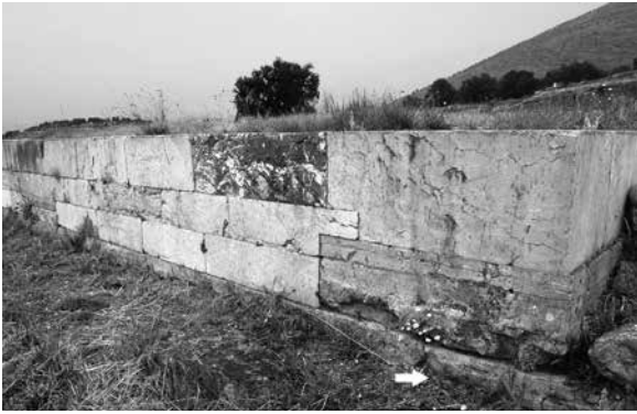
Abb. 7 Argos, Heraion, Bankettbau. Fundament der südlichen Außenwand mit oberster Lage der grob belassenen Quader (Pfeil). Aufnahme von SO
