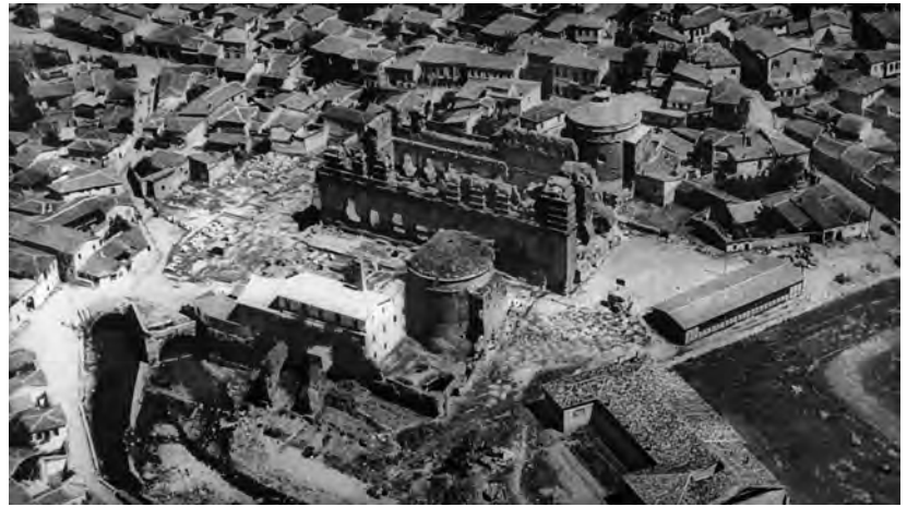
Abb. 85 Pergamon, Rote Halle. Luftaufnahme des Areals von Süden um 1940, im Vordergrund der südliche Rundturm, davor das teilweise eingestürzte Kellergewölbe, die Stützmauer mit den beiden Strebebögen und die beiden Tunnelröhren des Selinus
