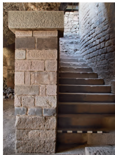
Abb. 93 Pergamon, Rote Halle. Der neu entdeckte Treppenaufgang, der am südlichen Rundturm hochführt, links die bereits restaurierte Türwange des Durchgangs
