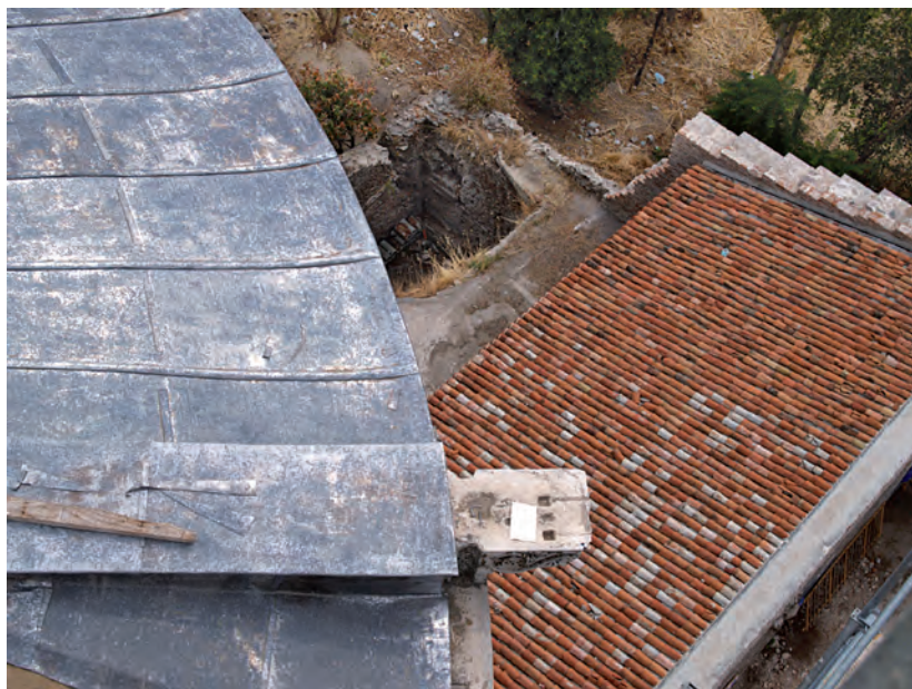
Abb. 92 Pergamon, Rote Halle. Aufsicht auf die in Eindeckung befindliche Kuppel des Rundturms, das Dach des neuen Depotgebäudes und davor liegend der eingebrochene Abschnitt des Gewölbes
