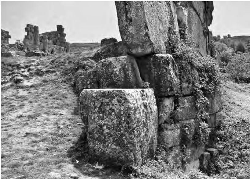
Abb. 12 Quellaustritt unter der westlichen Temenosmauer
