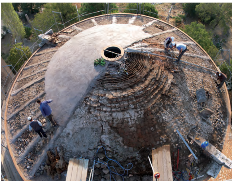
Abb. 77 Pergamon, Rote Halle. Aufbringung der Ausgleichs- und Decklage aus Kalkmörtel auf der Kuppel
