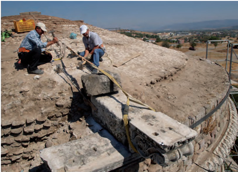
Abb. 75 Pergamon, Rote Halle. Sicherung der südwestlichen Marmorkonsole des antiken Traufgebälks mit zwei Edelstahlankern
