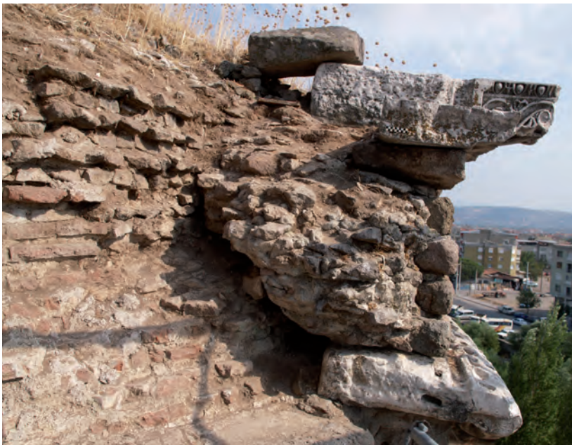
Abb. 71 Pergamon, Rote Halle. Die südwestliche der beiden antiken Marmorkonsolen des Traufgebälks in gefährlicher Schräglage mit dem vom Verband gelösten Unterbau und dem 1968 aufgelegten Andesitquader
