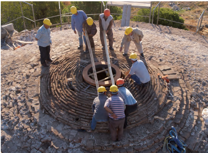
Abb. 76 Pergamon, Rote Halle. Versetzen des Druckrings aus Stahl in das durch die Vermauerung reduzierte Opaion
