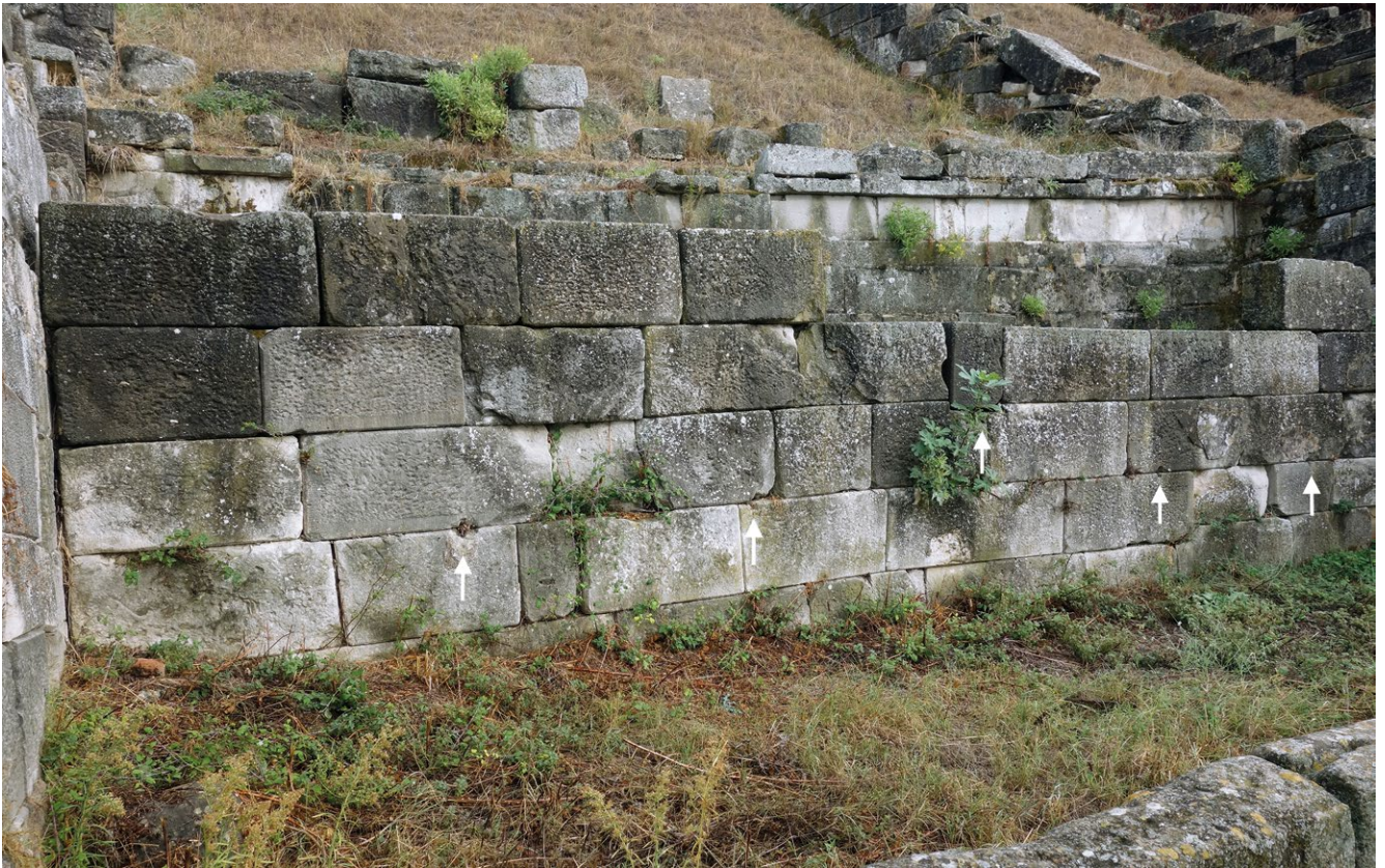
Abb. 22: Apollonia, Brunnenhaus. Trennwand zwischen dem Klär- und dem Schöpfbecken mit fünf Durchlässen (weiße Pfeile)
