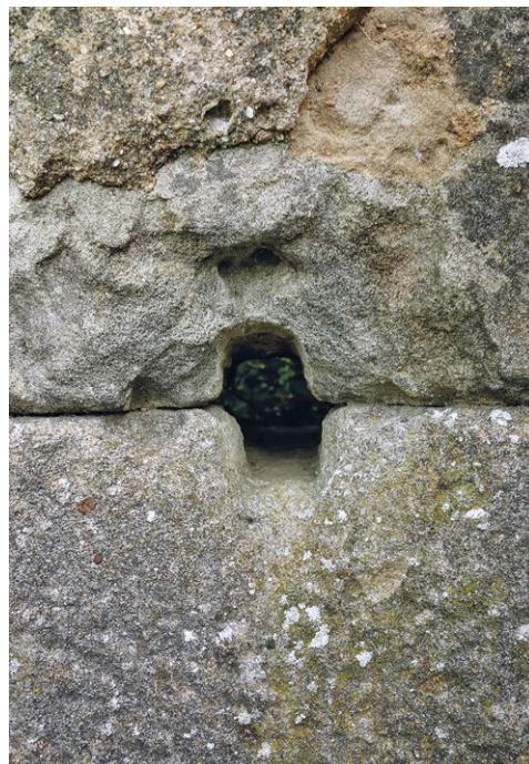
Abb. 22: Apollonia, Brunnenhaus. Trennwand zwischen dem Klär- und dem Schöpfbecken mit fünf Durchlässen (weiße Pfeile)
