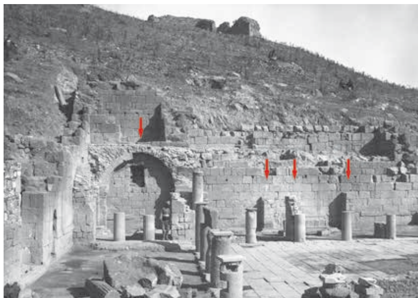
Abb. 15 Pergamon, Stadtberg. Untere Agora, westliches Ende der Nordhalle unmittelbar nach der Ausgrabung. Blick von Süden, mit Pfeil markiert: die sekundär eingezogenen Pfeiler der kaiserzeitlichen Reparaturmaßnahme sowie der Ansatz des zugehörigen Kreuzgewölbes in der Nordwestecke
