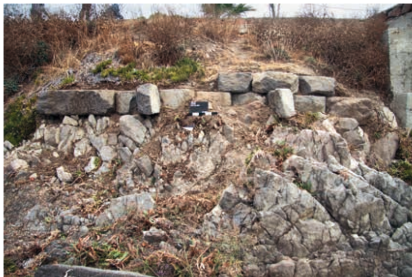
Abb. 65 Pitane, antike Seemauer. Ansicht von Westen
