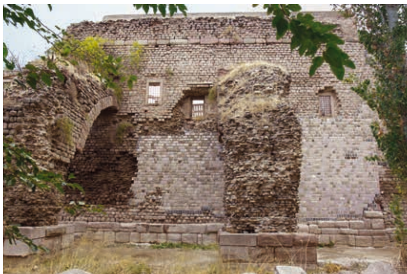
Abb. 87 Pergamon, Rote Halle. Ergänzte Mauerschale an der südöstlichen Begrenzung des Temenos, Ansicht von Süden
