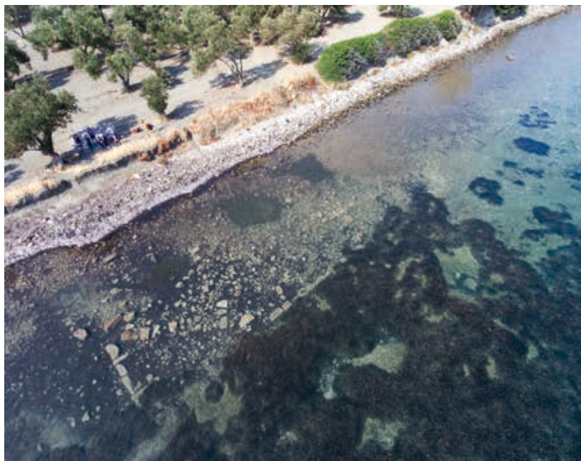
Abb. 59 Kane, Ostbucht. Baureste der älteren Befestigung, ummantelt von der Quaderschale der hellenistischen Stadtmauer. Luftaufnahme von Südosten
