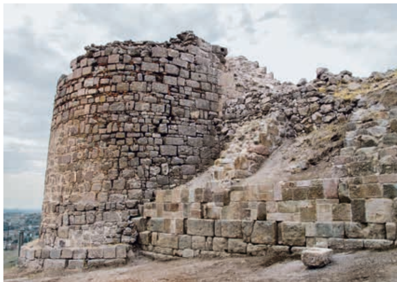
Abb. 86 Pergamon, Gymnasion. Konsolidierter Abschnitt der Stützmauer der mittleren Gymnasionsterrasse mit den spätbyzantinischen Verteidigungsanlagen, Ansicht von Osten
