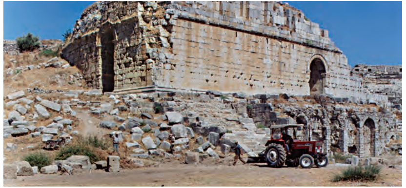
Abb. 19 Steinversturz vor der Südwestecke
