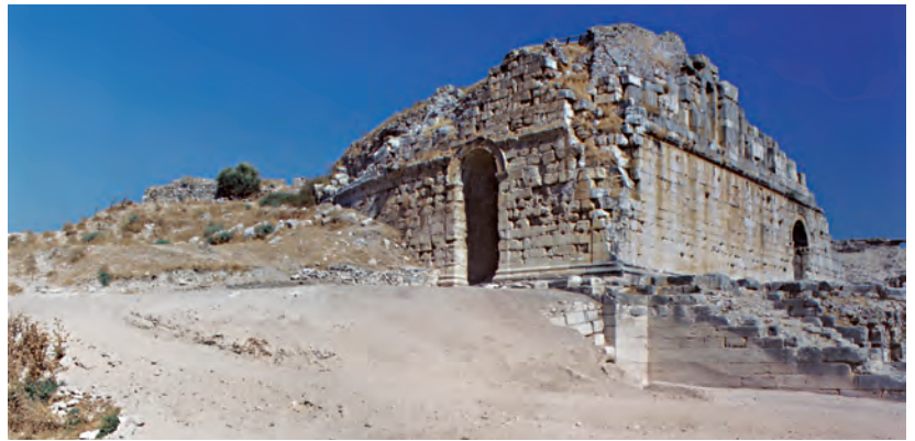
Abb. 20 Neuer Zugang zum Westeingang und erweiterte Ansicht der Freitreppe
