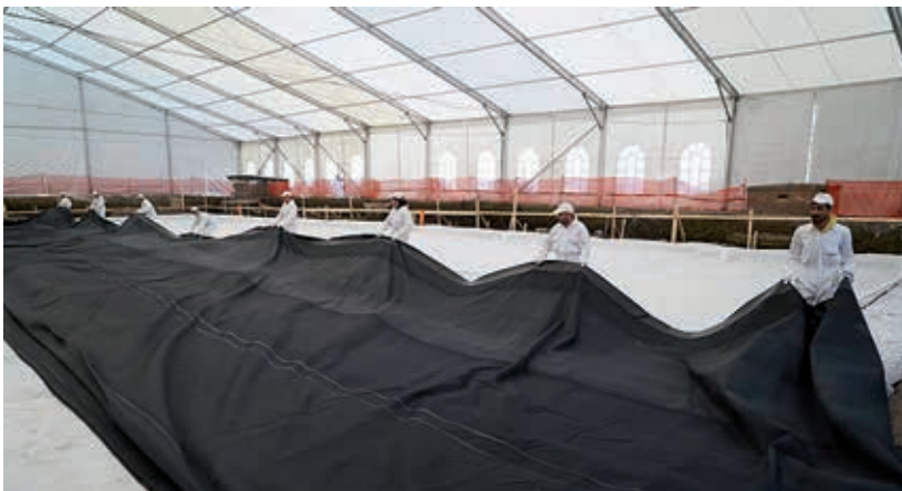
Abb. 33 b Domus Aurea, die wichtigsten Schritte in der Umsetzung des SIP. Lage aus undurchdringlicher Membran mit einer isolierenden Lage aus Schaumglas, das die restaurierte antike Oberfläche bedeckt
