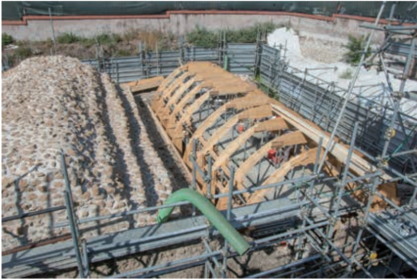
Abb. 28 Domus Aurea, Bereich der sog. Casermette. Raum 17 und 18, Blick während der Rekonstruktion der Gewölbe
