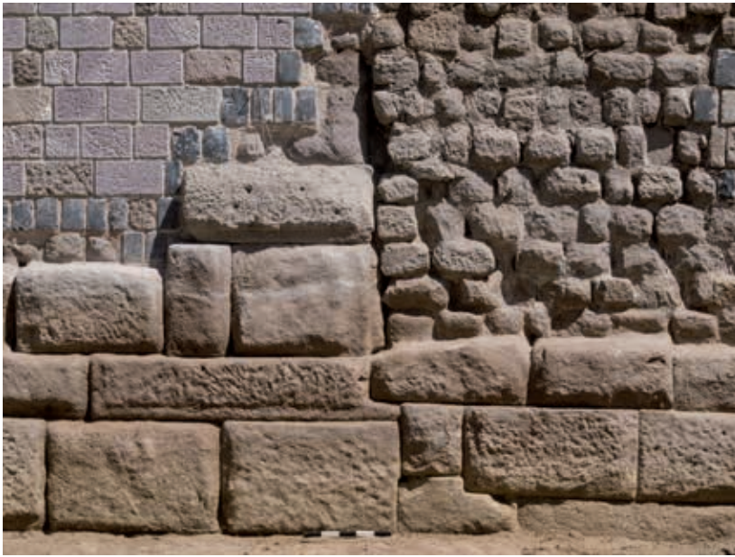
Abb. 72 Pergamon, Rote Halle. Die 2015 neu entdeckte Sockelzone der südlichen Stützwand mit dem rustizierten Großquadermauerwerk
