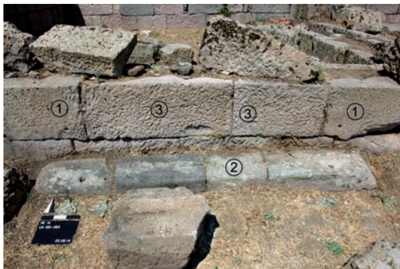
Abb. 52 Pergamon, Stadtberg. Untere Agora, Raum 2. Südliche Front des Raumes mit ursprünglicher Türlaibung (1), sekundär vorgelegter Schwelle (2) und nachträglicher Türzusetzung (3)
