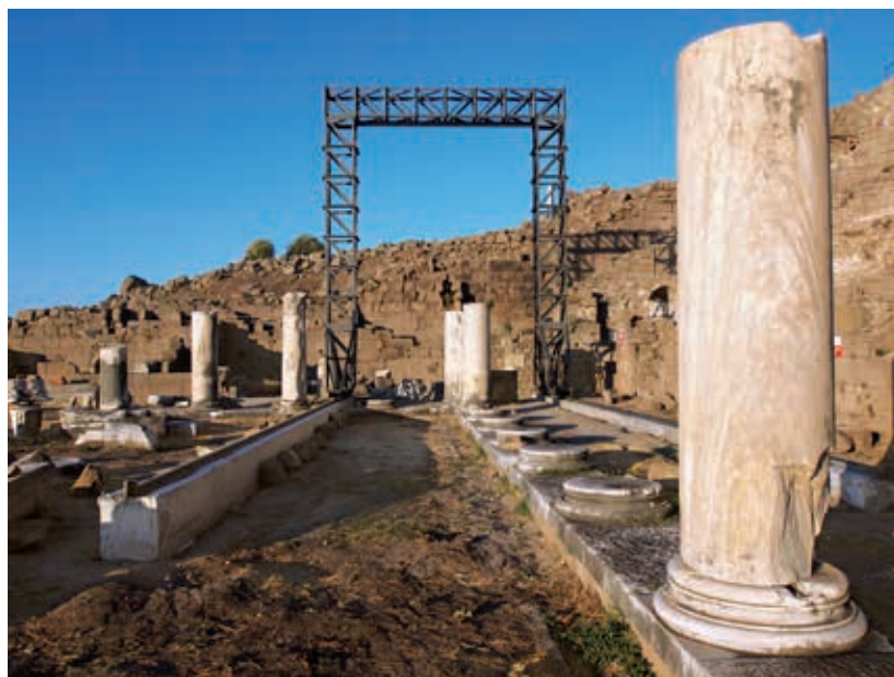
Abb. 95 Pergamon, Gymnasion. Der fertig montierte Portalkran in der Nordostecke der Palästra
