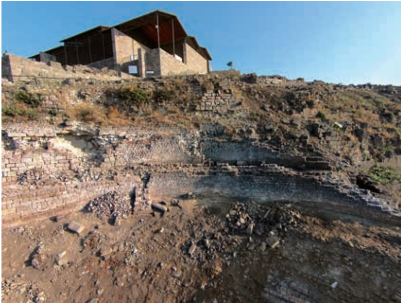
Abb. 96 Pergamon, Gymnasium. Oktokopteraufnahme der vom Schutt befreiten und gereinigten Cavea des Odeions mit den großflächigen Schadstellen vor Beginn der Restaurierungsmaßnahmen
