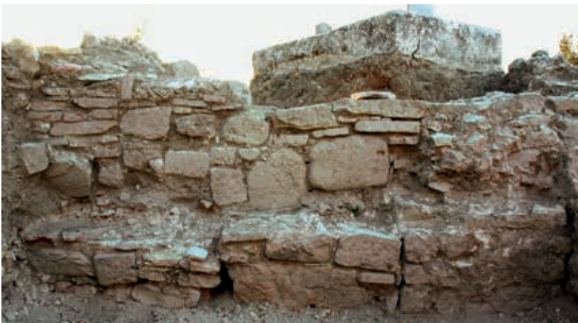
Abb. 34 Milet, Südstadtthermen. Vestibül, südlicher Teil der Ostwand: rechter Abschnitt aus Phase II, mittlerer aus Phase III, darüber osmanisches Lehmörtelmauerwerk, zuoberst Grab aus dem 20. Jh., von Westen
