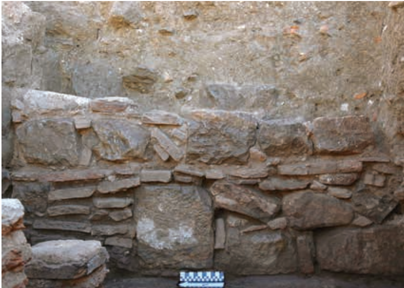
Abb. 74 Milet, Südstadtthermen. Son- dage 01, Lehmörtelmauer vor dem Ostprofil, von Westen
