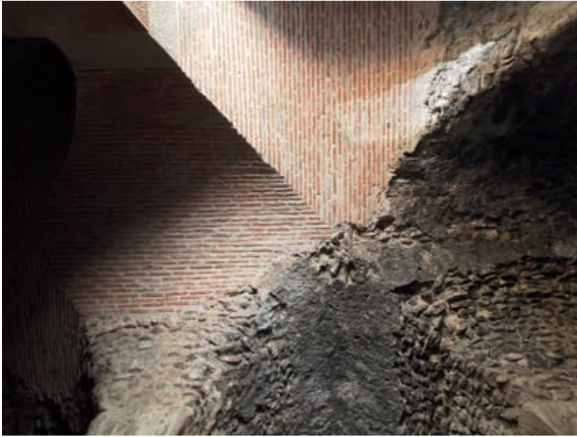
Abb. 68 Pergamon, Rote Halle. Ergänzte Gewölbeabschnitte aus Ziegelmauerwerk und der Originalbestand im römischen Gewölbekeller des südöstlichen Temenosbereichs
