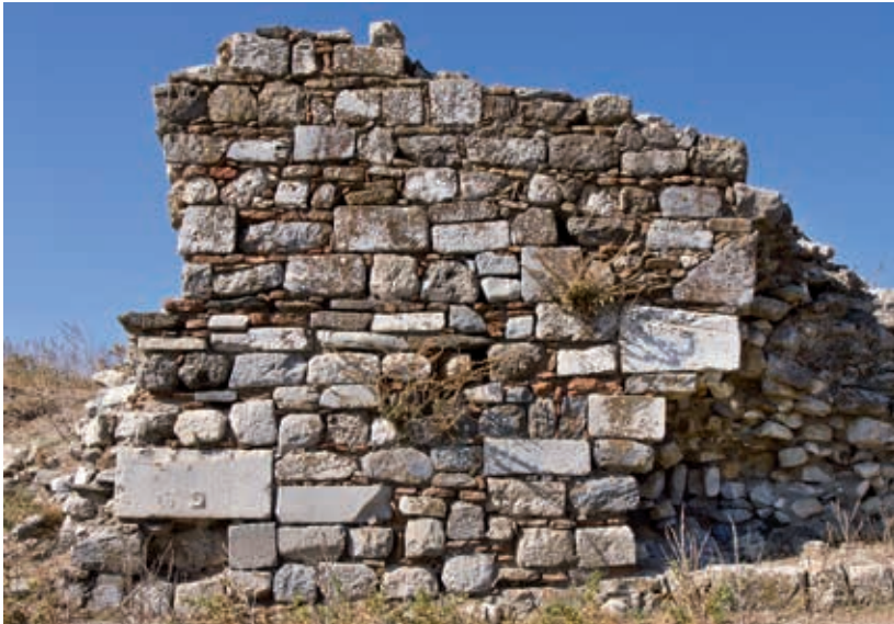
Abb. 81 Milet, Theaterhügel. Feldseite der Kurtine Nr. 37 von Nordosten, teilweise Kästelmauerwerk
