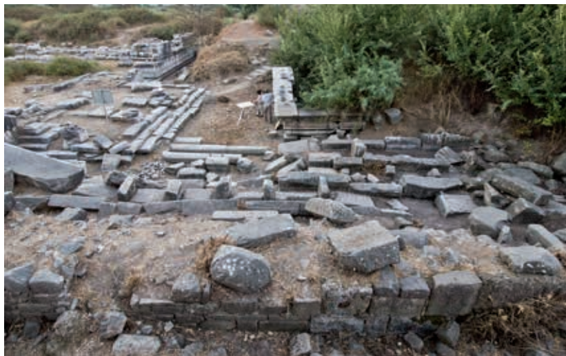
Abb. 21 Milet, byzantinische Stadtmauer. Kurtine K 40 südlich des Serapeion (links), von Westen: hinter der Mauer die pseudoisodome östliche (äußere) Mauerschale in Sturzlage
