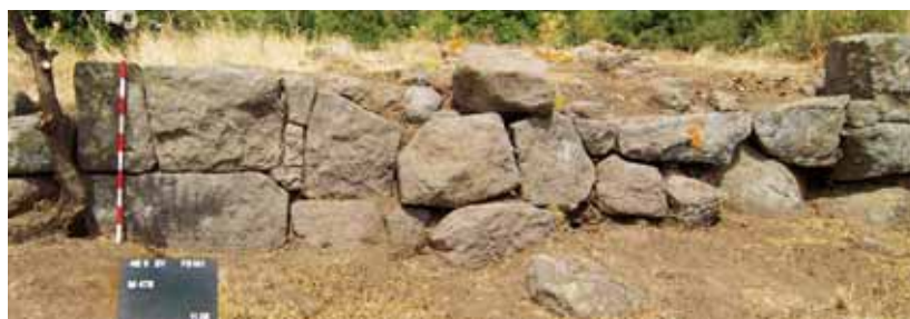
Abb. 28 Assos, Oststadt. Polygonale Mauern in der Oststadt, Mauer M478 von Osten 2011
