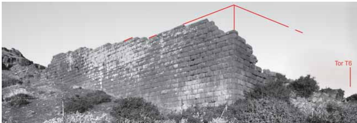
Abb. 3 Assos, Westflanke der Stadtmauer. Mauerecke t11 und Kurtinen k16 und k17 von Westen 2012
