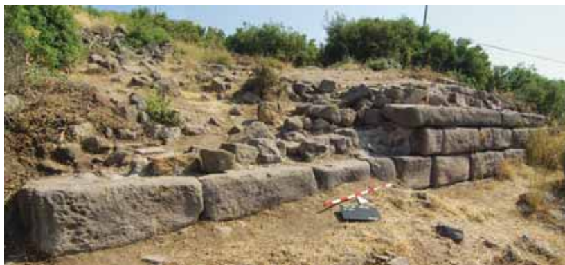
Abb. 32 Assos, Quadermauern im Stadtgebiet. M350 in der Südoststadt von Süden 2011
