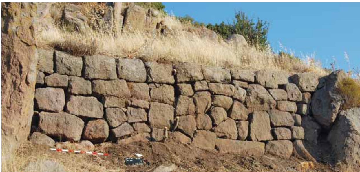
Abb. 24 Assos, Südostabhang der Akropolis. Terrassenmauer M524 von Südosten 2011
