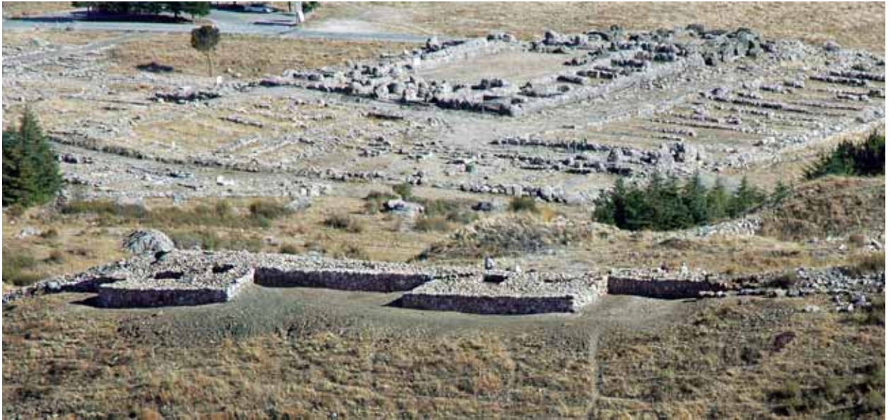
Abb. 9 Boğazköy-Hattuša, der Zustand der Poternenmauer nach Abschluß der Restaurierungen (Blick von Süden)
