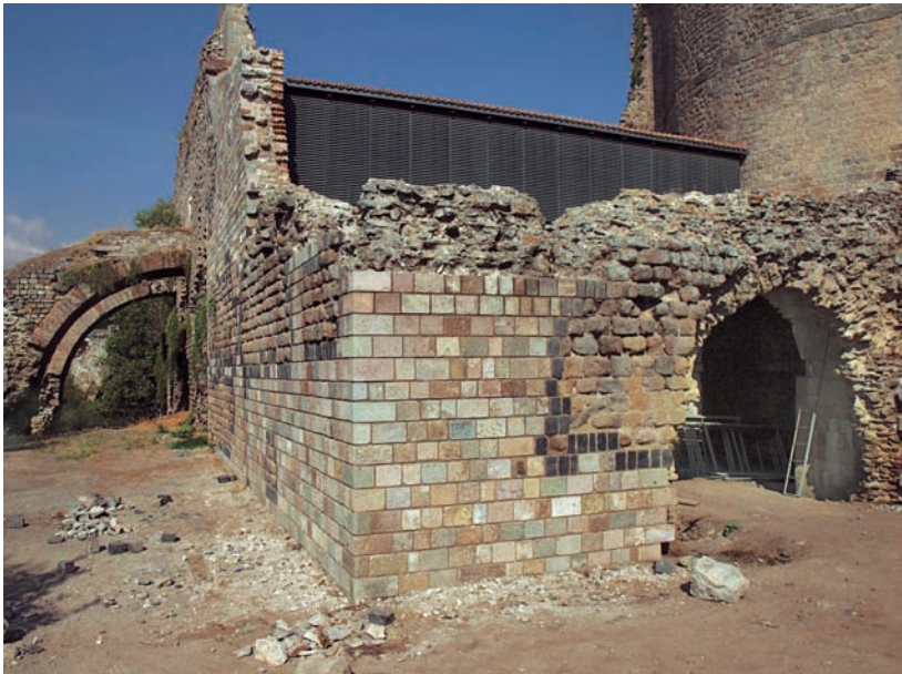
Abb. 118 Außenansicht des Kellers mit den 2010 restaurierten Bereichen der Umfassungswände
