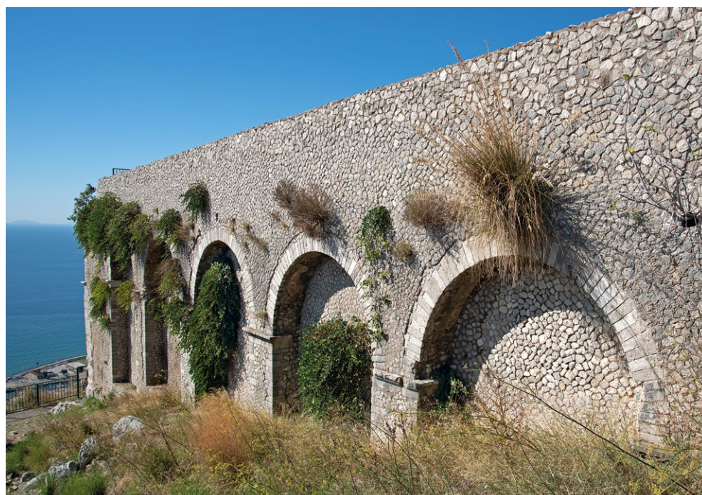
Fig. 16: Sostruzioni del Grande Tempio: quattro archi ciechi del muro di sostruzione orientale con la rampa che collega i due livelli delle terrazze
