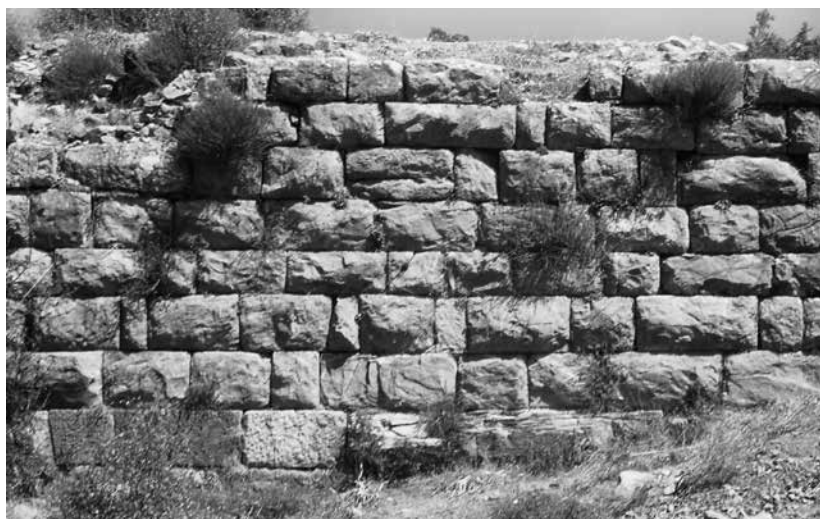
Abb. 35 Kaunos, PT 1995. Südabschnitt der PT-W-Mauer von Westen
