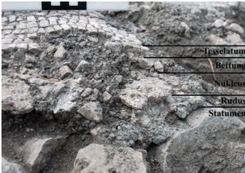
Abb. 40 Aufbau des Mosaiks aus fünf verschiedenen Schichten, von unten nach oben können Statumen, Rudus, Nukleus, Bettung der Tesserae und Tesselatum unterschieden werden
