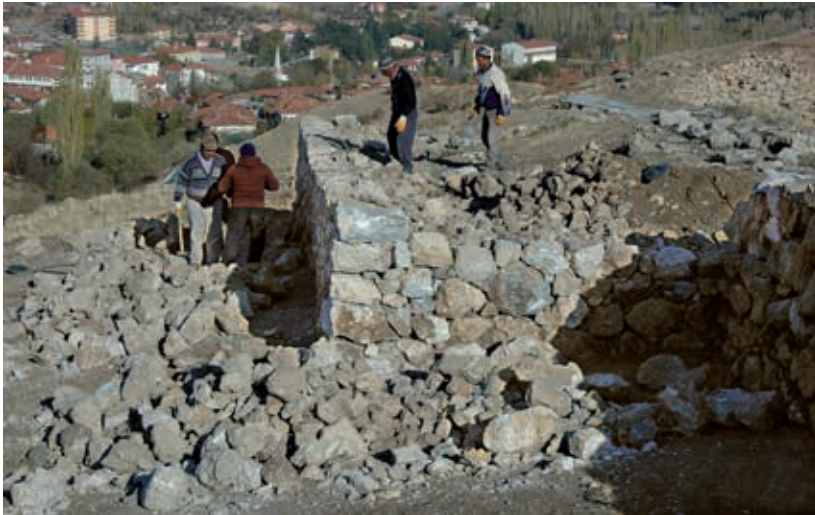
Boğazköy-Ḫattuša, Arbeiten an der Poternenmauer
