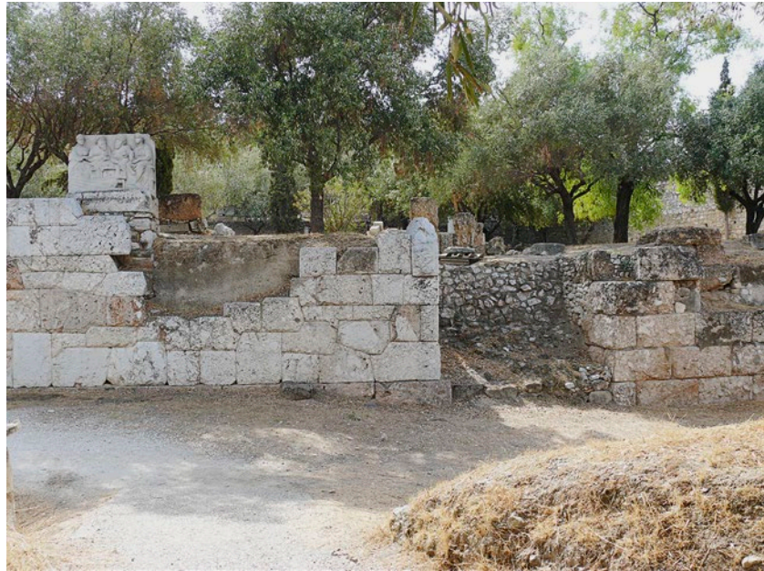
9 Kerameikos, 2013, Ansicht des westlichen Teils der Fassade des Lysimachidesbezirks mit Fehlstelle und des westlich daran anschließenden Weges. Im Zuge der Restaurierungen von 1914/1915 wurde die Böschung abgestützt und unter der Leitung Dieter Ohlys (1959–1965) mit Zement vergossen
