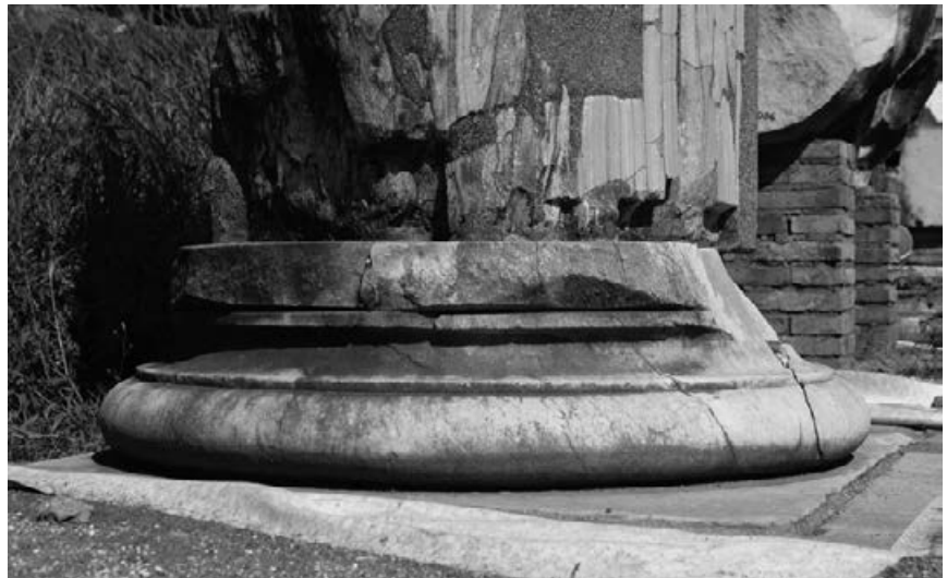
Abb. 7b Basilica, unteres Stockwerk, nördliche Säulenlängsreihe, attische Säulenbasis, Ser.Nr. 198151
