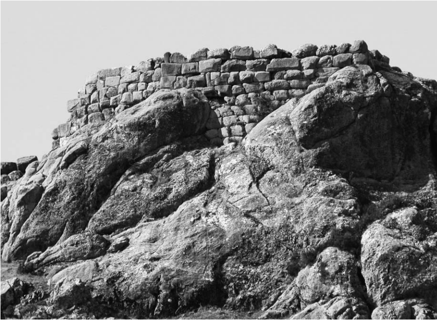
100 Die Ostfassade von Yenicekale
