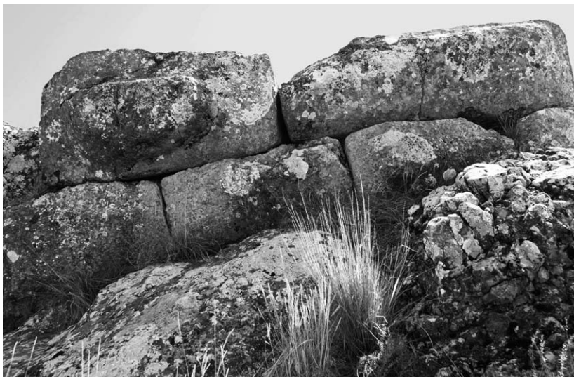
103 Yenicekale, Mauer 07-530 auf der Nordseite, einige der Steine weisen noch Bossen auf; sie sind nicht fertig ausgearbeitet worden
