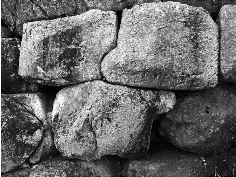
102 Yenicekale, Mauer 07-527 auf der Ostseite, Beispiel für verschränkte Steine
