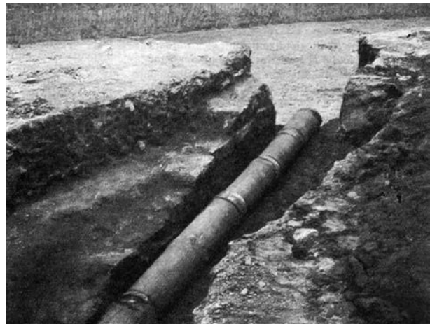
Abb. 112. Die von K. Bittel 1928 vor der Lagersüdecke in situ angetroffene Wasserleitung 02.05 aus fünf Tonröhren.
