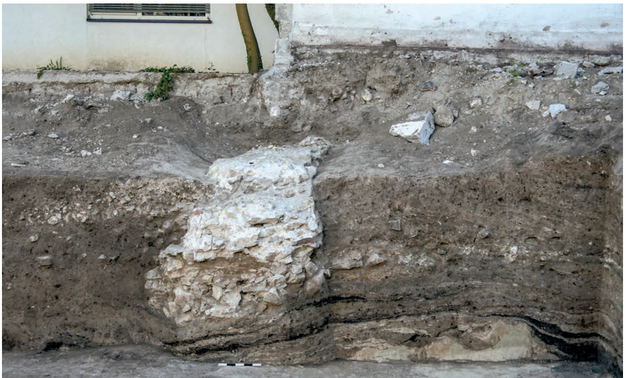
Abb. 81. FS 12a, Profil 12a E-F. Detailaufnahme des Fundamentes der Lagermauer 12.01, das ohne Fundamentgraben direkt auf den Schuttschichten 12.12 aufsaß, sowie der Mauervorblendung 12.04 (vgl. Abb. 73 ; Beil. 5 ).
