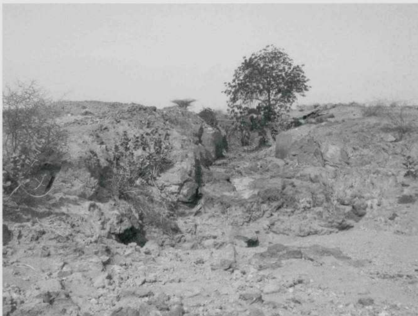
Fig. 5 Canal nord: sortie du canal, (vue vers l'ouest).
