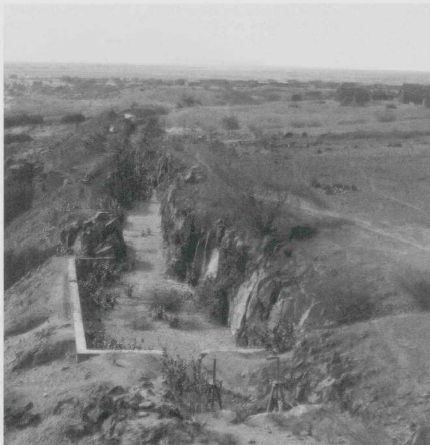
Fig. 9 Canal sud: avec aménagements récents (bassins en béton).
