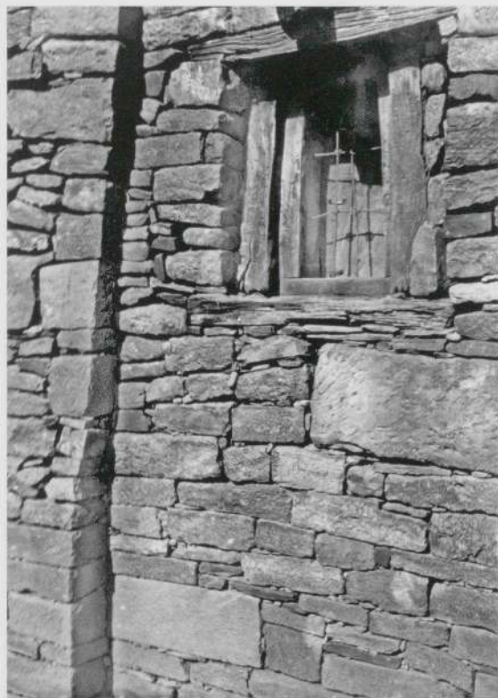
Abb. 3 ʿĪnda Abunä Afṣe: Fenster in der östlichen Mauer (Foto: DAE 559 = MBA 2255.04).
