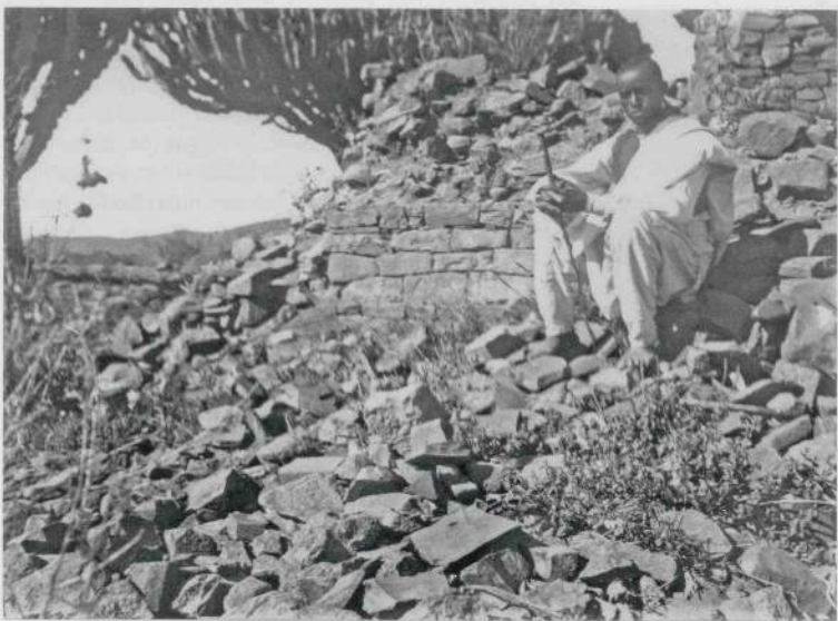
Abb. 3 Qəddus Mikā'el bei Dəbarwa: Mauerwerk des Podiums (Foto: DAE 591 = MBA 2216.03).
