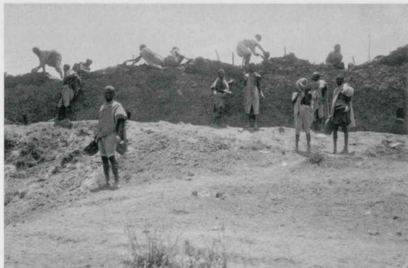
Abb. 17 Bau einer Steinmauer (Foto: DAE 873).
