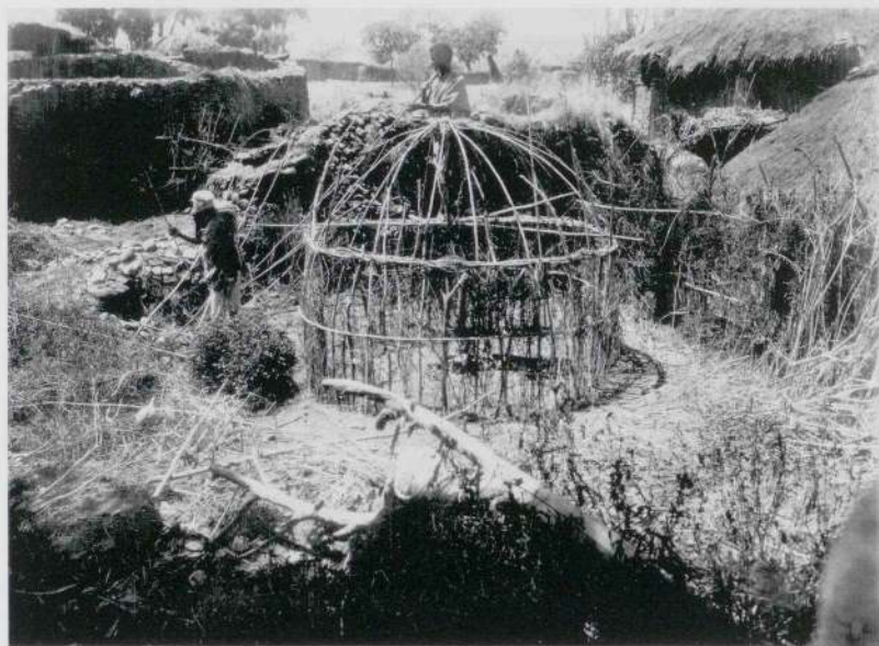
Abb. 16 Gerüst einer Rundhütte (Foto: DAE 877 = MBA 2247.12).
