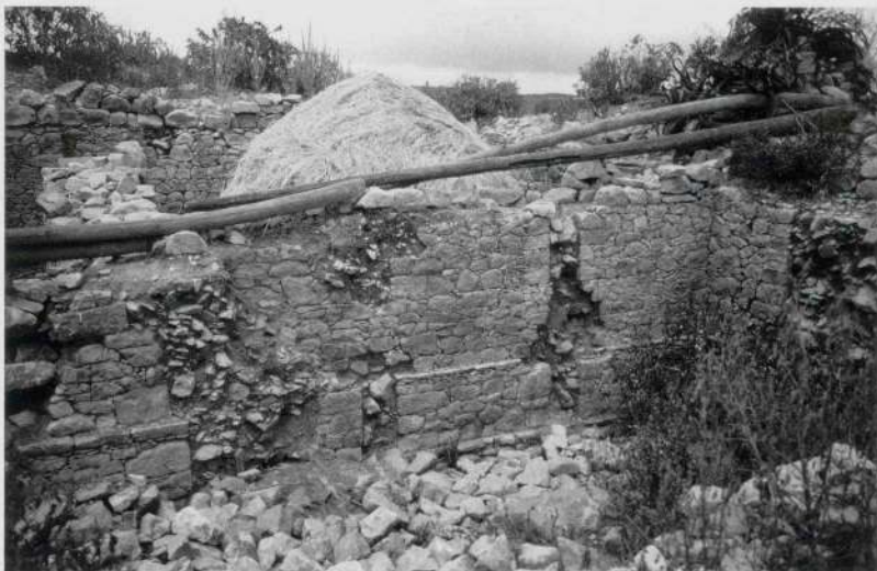
Abb. 13. Safira auf Qohayto. Aksumitische Wohnhäuser, die von der Bevölkerung als Speicher verwendet werden. Man beachte die schmalen, senkrechten Aussparungen im aufgehenden Mauerwerk (Foto: St. Wenig 1995).
