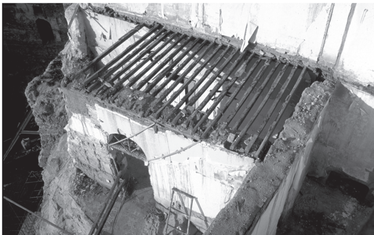
Fig. 10 Callejón de San Pedro n° 18: état actuel d'un palacio médiéval.
