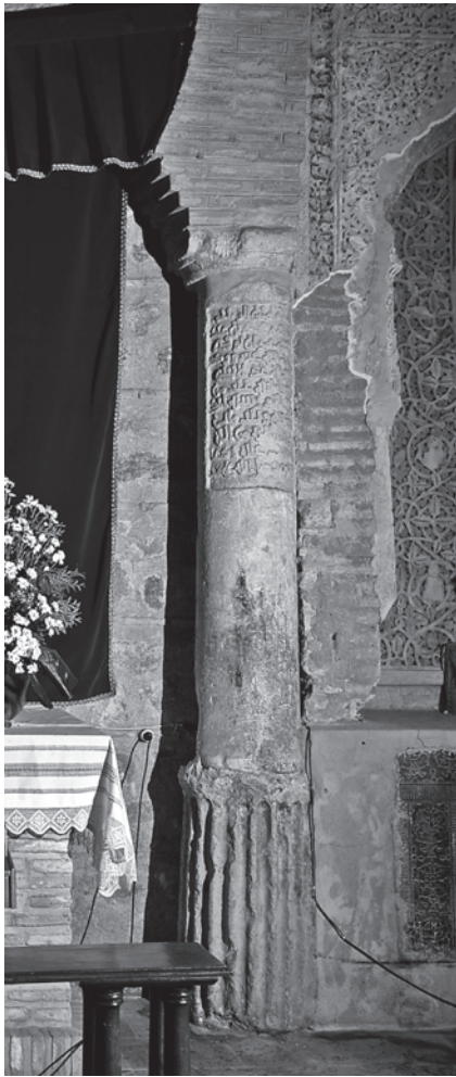
Abb. 28. Säulenschäfte S1 (oben) und S2 (unten) im Bauverband.
