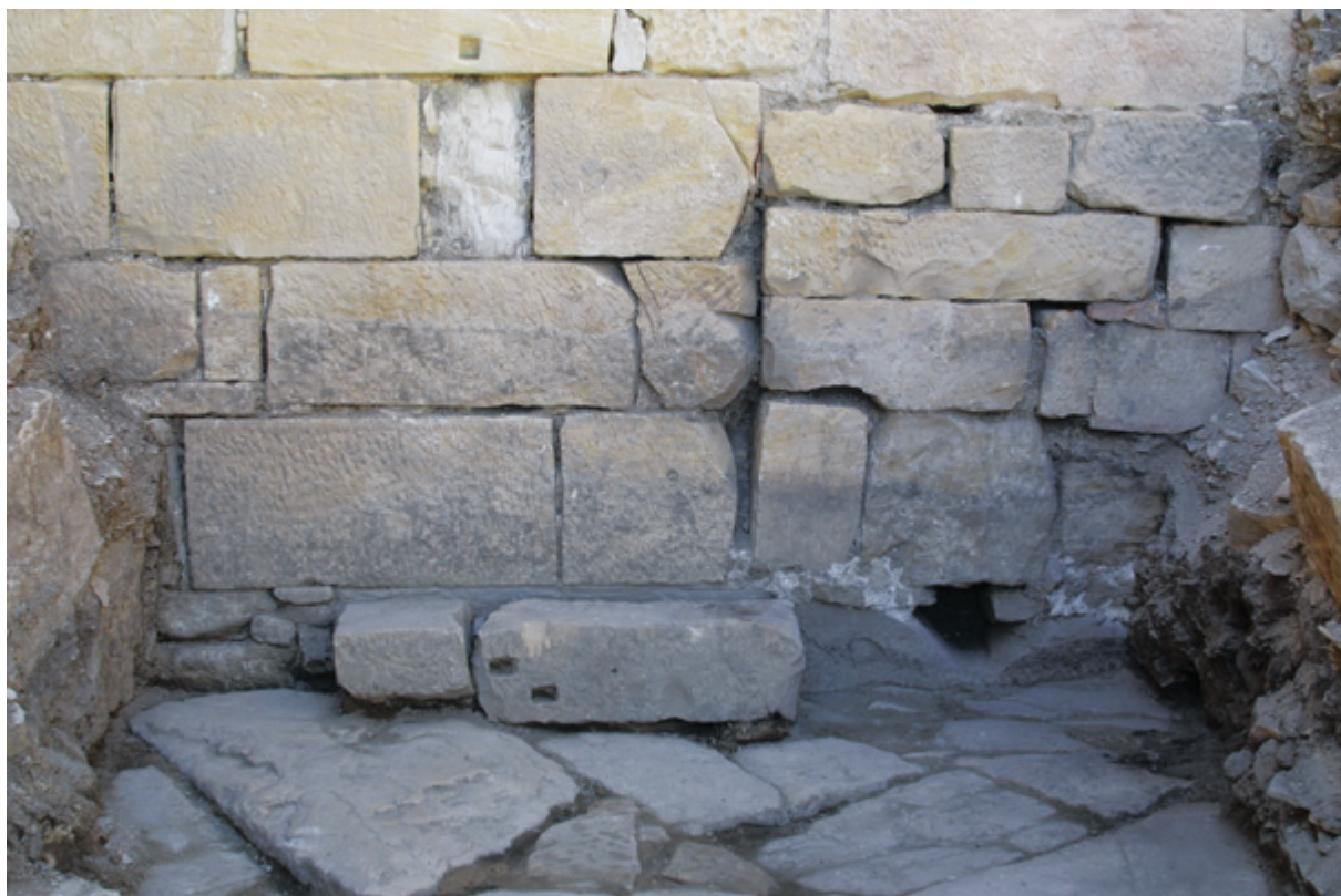
6 Ammaedara. La porte orientale de la citadelle, côté extérieur. On distingue au premier plan le dallage de la voie de Carthage, puis à gauche le mur byzantin et à droite le bouchage (médiéval ?) de la porte
