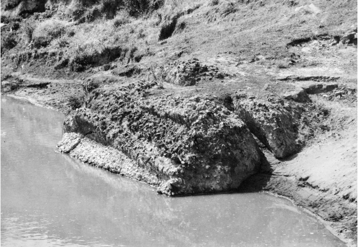
1 Ufermauer Süd-Ost, östliches Teilstück, Sturzmasse
