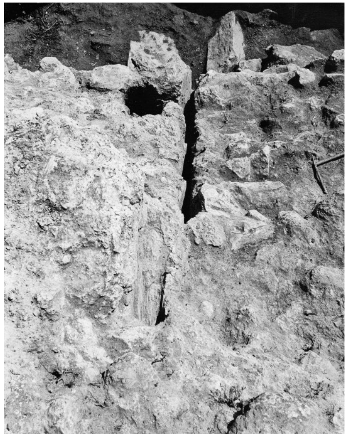
3 Plateau, Bereich C, Arbeitsfuge östlich von Pfeiler I
